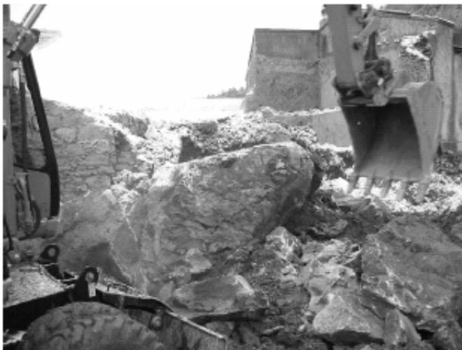
Estrazione di massi erratici nel settore del magazzino sotterraneo della truppa
