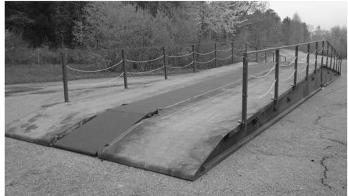
Jeu de pont de 26 m avec recouvrement de la partie médiane et garde-fou
