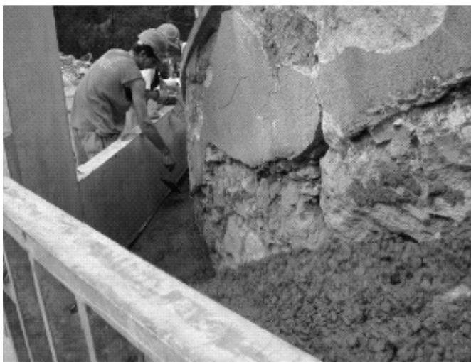
Construction en sous-cœuvre des fondations de façades
