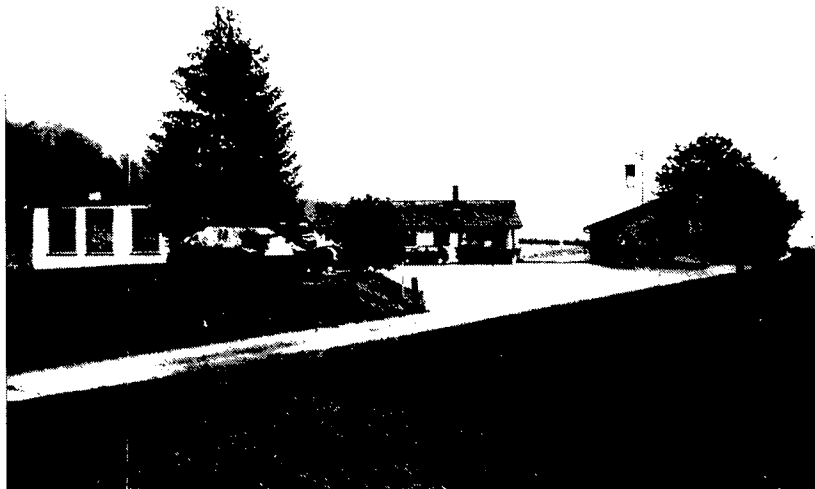
Infrastructure des bâtiments sur la place de tir de Vugelles-La Mothe
